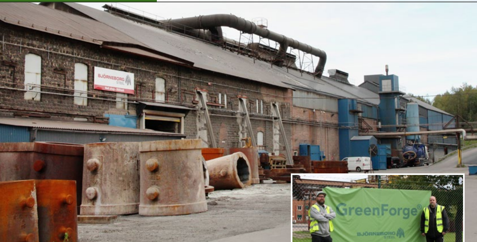
Björneborg Steel AB stålverk har anor från 1656. Här syns byggtäckning från början av 1900-talet, sintersten via tegelvägg på 1950-talet till senaste utbyggnaden i korrugerad plåt. Bilden till höger: Green Forge är namnet på den nya, gröna, satsningen. Janne Malinen och Jonas Bergqvist poserar vid logotypen. Målet är att produktionen ska vara fossilfri 2026.
