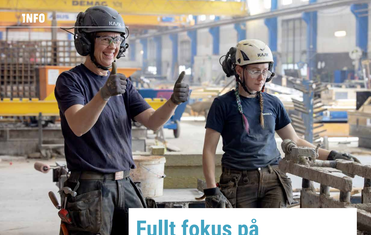
Jenny Sohlín och Matilda Linnér har precis knuffat den vibrerande avdragsbryggan över formen med våt betong.
