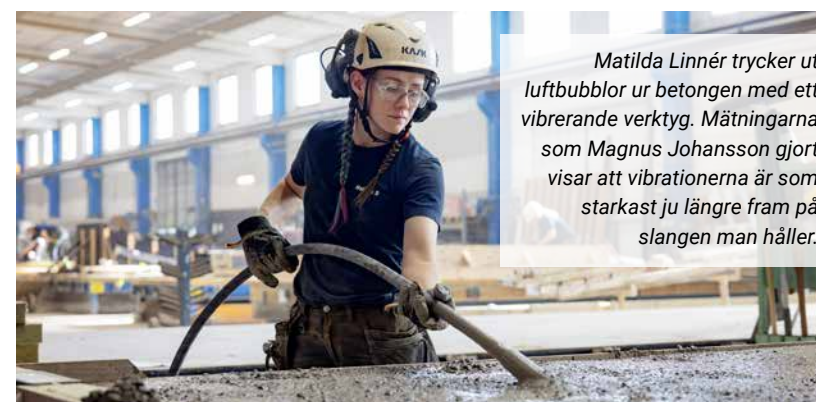
Alla vibrerande verktyg är märkta med ett värde som anger hur mycket de vibrerar så att användaren vet hur länge det är säkert att köra dem.
